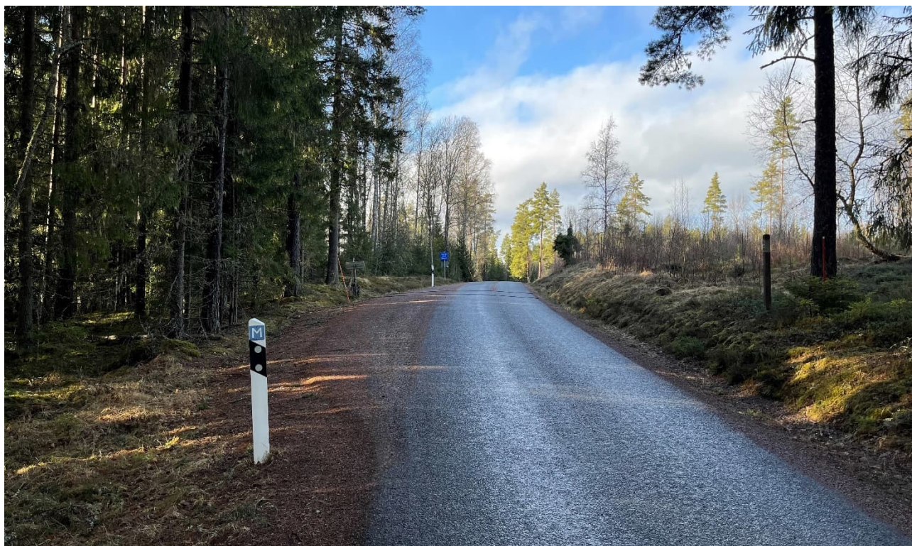
Figur 62. Exempel på mötesplats längs väg 17060, som markeras med "M" på sidomarkeringsstolpen.
