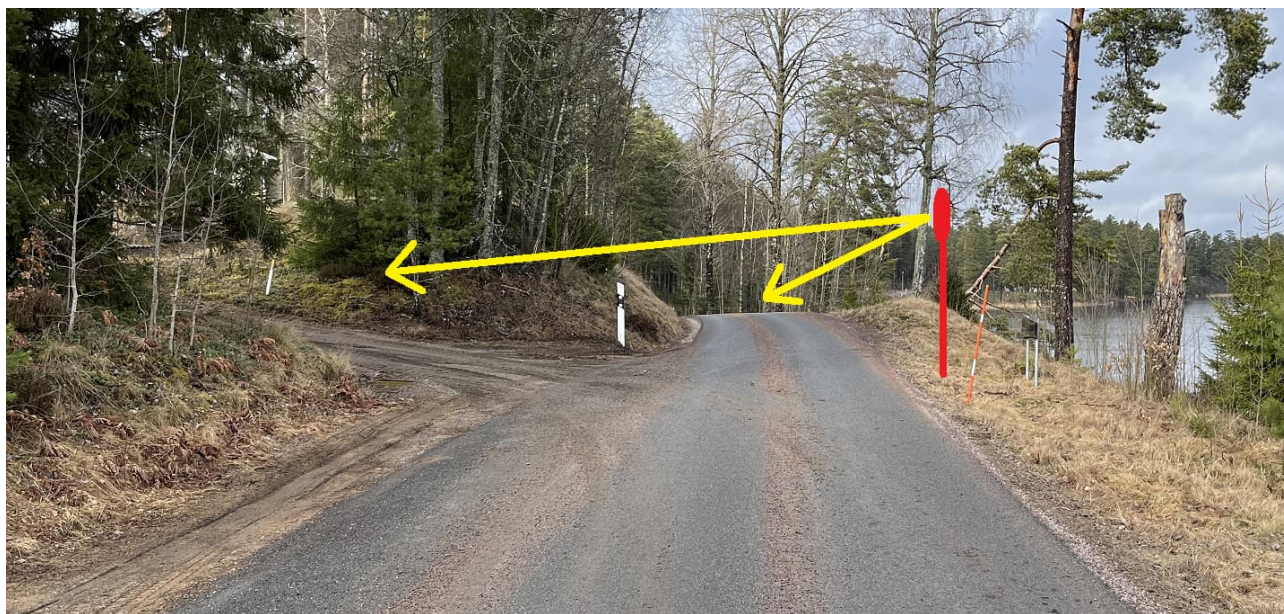
Figur 72. Grovt montage tänkbar placering av trafikspegel (röd illustration). De gula linjerna symboliserar mellan vilka riktningar som spegeln riktas. Trafik norrifrån längs väg 17060 (bortifrån i bild) ser trafik från sidovägen (vänster i bild) och vice versa.
