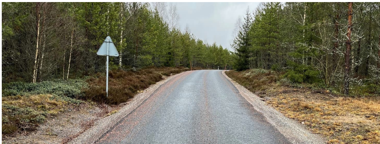
Figur 17. Väg 17060 strax norr om dess södra ände, vy åt nordost. Generellt bedöms den sydligaste sträckan ha lite bättre geometri än övriga sträckor längs väg 17060, vilket innebär en aningen högre uppskattad bekväm färdhastighet på uppskattningsvis cirka 50 – 60 km/h (vilket också slangmätningens hastighetsmätning för den södra punkten bekräftar, se Bilaga 1).
